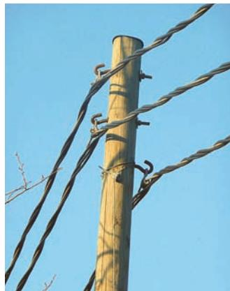
Арматура линейная – детали и приспособления для крепления изоляторов к опорам (мачтам) и проводов к изоляторам для воздушных линий электропередач (ЛЭП). Основными потребителями данной продукции являются организации энергетического комплекса (строительство и обслуживание ЛЭП), подразделения РАО «ЕЭС России».
